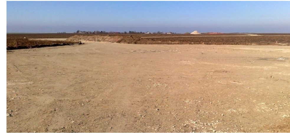
Figure 126 : Exemple d'aire de montage, grave compactée sur géotextile
