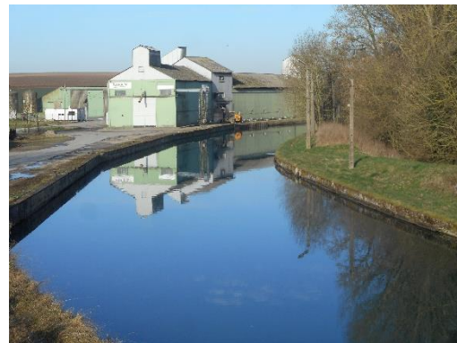
Figure 105 : Canal de Saint-Quentin – Territoire de Bellenglise (© ATER Environnement, 2016)
